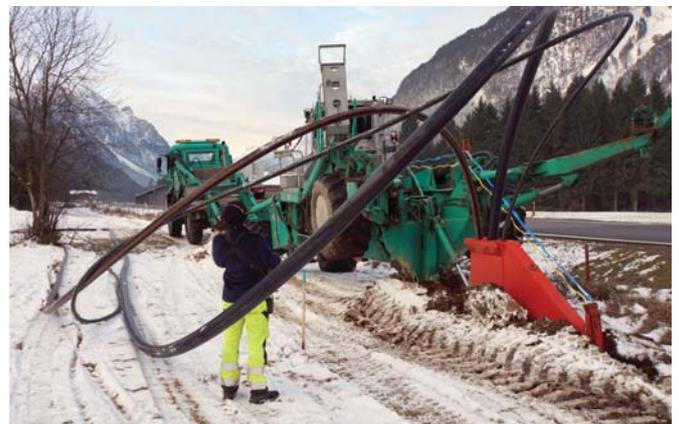
bzw. entwickeln können. Mit einer sogenannten "Pflügung" wurde die schnellstmögliche und kostengünstigste Methode zur Leitungsverlegung gewählt. Das Mehrfamilienhaus Oberried 48 (ehem. "Franzosenhäusle") kann dadurch ebenfalls an das Trinkwassernetz der Gemeinde angeschlossen werden. Auch die Löschwasserversorgung in diesem Bereich wurde damit verbessert. Zudem wurden bei der Leitungspflügung auch ein Abwasserkanalstrang und die Leerverrohrung für Breitband-Internet mitverlegt.
